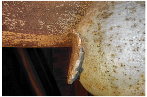
Schaden an der Klöppelkugel
